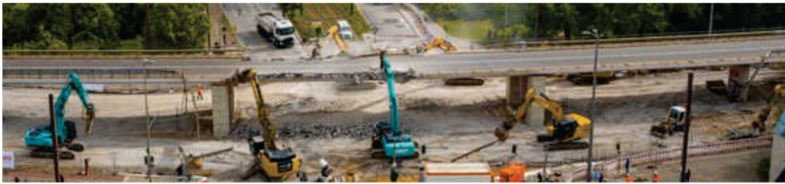
Abb. 10 - Foto zum Rückbau der Brücke „An der Wuhlheide“, Quelle: © Reinhardt und Sommer
