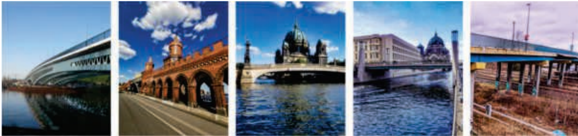
Abb. 5 - Bilder von Berliner Brückenbauwerken, Quelle: © SenMVKU
